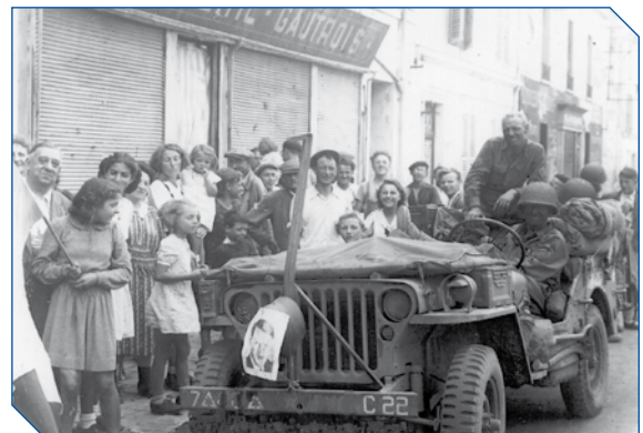
28 août 1944 Photo de groupe devant la boucherie Gautrois (aujourd'hui magasin de vêtements Grangé). La jeep est équipée à l'avant d'un « wire-cutter bar » (barre coupe fil), pour éviter que l'équipage de la jeep ne soit décapité par des fils de fer tendus en travers de leur route. Archives Ch. Paul/Cl. Demarque
